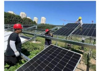
この施設は、約3,000枚の太陽光パネルを備え、システム全体の発電容量は1.6MW、年間200万kWhを超える発電が見込まれています。これにより、当初の電力消費量の10分の1が代替され、年間約2,000トンのCO<sub>2</sub>が削減されます。
