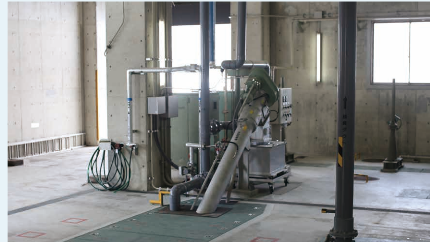
ロータマットスクリーン設置例
