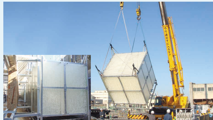
既存の前曝気槽に微生物接触ろ材を沈め、反応槽として対応
