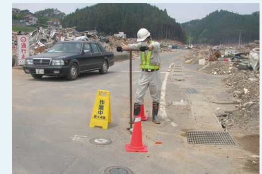
災害発生後の通水作業
