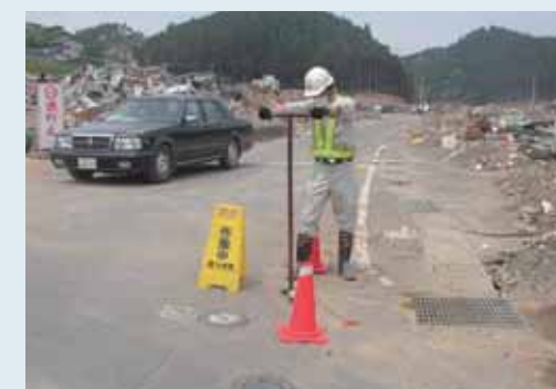
災害発生後の通水作業
