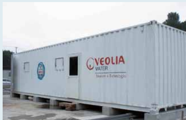
南三陸町に設置した緊急浄水システムおよび移動式逆浸透膜装置
