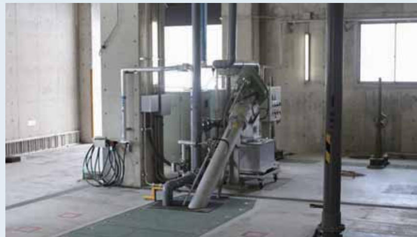
ロータマットスクリーン設置例
