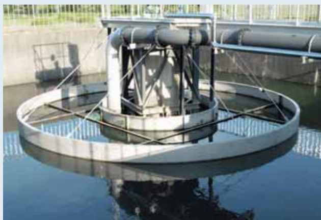
ロータリーフィン汚泥掻寄機設置例
