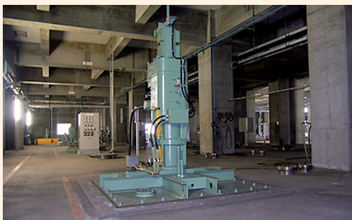
終末処理場のバルブスキッドと曝気機
