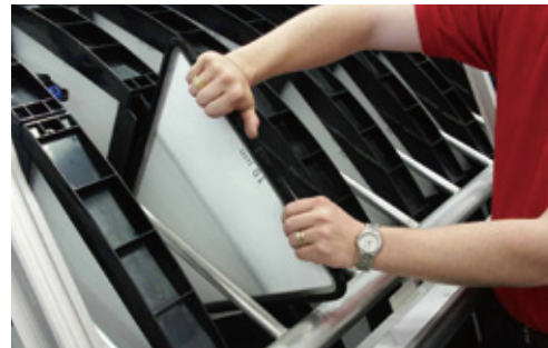
フィルター交換作業
